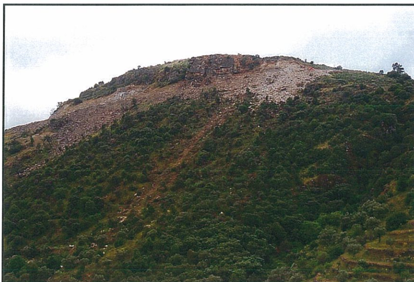
Figura 4.25 – Vista geral da parcela 9, onde em cima quase não se vê a intervenção, enquanto que em baixo é perceptível que desmataram até à parcela e que foi criado um acesso na bordadura.
